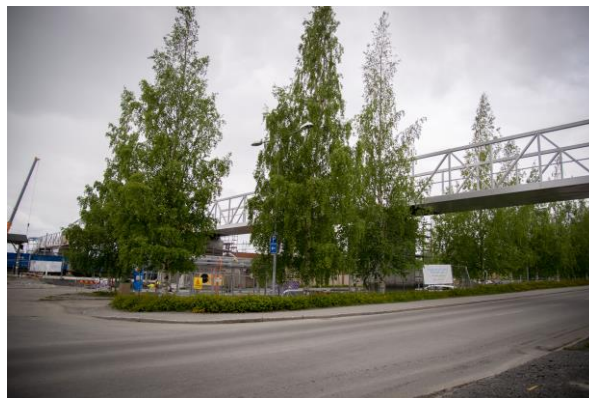
Just nu byggs en ny gång- och cykelbro från Österängsparken vid Östersunds centralstation till Storsjö strand.
