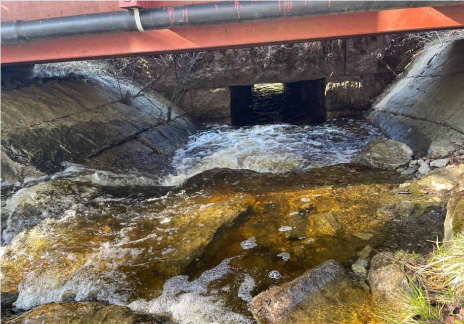
Figur 6-7. Opevägen, stentrumma under bilväg. (bredd = 1,4 m och höjd = 1,2 m) samt gångbro uppströms.
