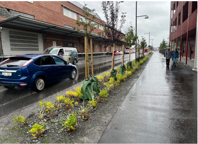
Krossdike längs Bangårdsgatan med träd och planteringar av blommande och bärande träd och buskar för att tillföra funktion för biologisk mångfald och upplevelse. Här finns inga kantstenar utan vattnet får rinna fritt ut på ytan.
