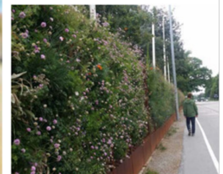
Exempel på bullerskärm med poröst växtsubstrat och växter i (växtvägg) från Lidingövägen i Stockholm. Bild från C/O City, 2017. Gröna lösningar ger levande städer.
