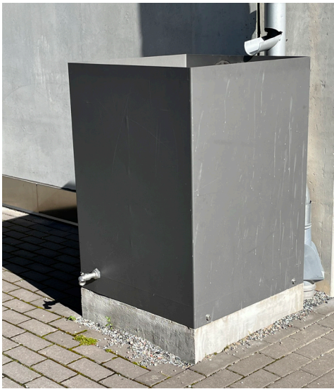
Exempel på regntunna för uppsamling av vatten
