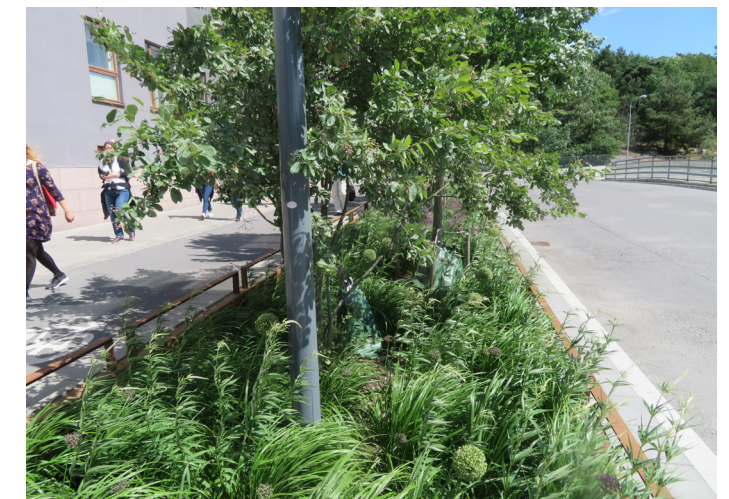
Ovan två exempel på regnbäddar och breda planteringar i gatumiljö för fördröjning och rening av dagvatten. Bilder från Stockholmsområdet. Regnbäddarna behöver utformas så att de fungerar i ett kallare klimat.
