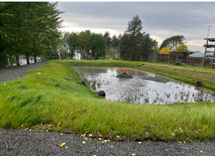
Befintligt biofilter efter regn. Runt biofilterdammen finns ängsvegetation för att skapa funktion för biologisk mångfald och upplevelse.
