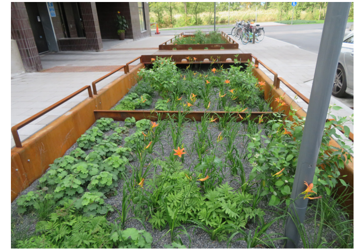
Regnbädd med växter planterade i makadam. Dagvattnet leds in via brunnar till regnbädden.
