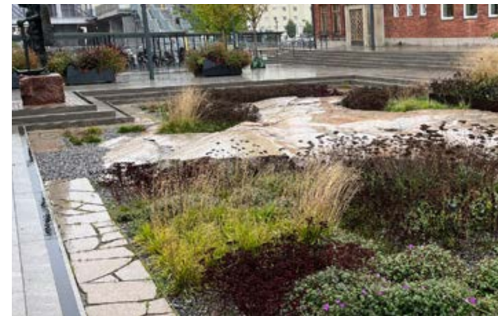
Exempel på en gestaltad dagvattenhantering inom parker och torg. Fotot visar en nedsänkt yta för skyfallshantering med planteringar. , WSP 2023.
