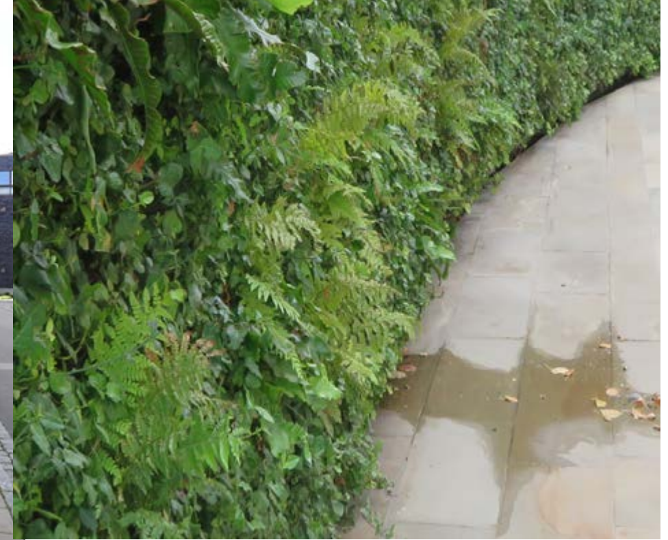
Växtväggar som utformas för att ge god bullerdämpning kan anläggas på vindskyddade platser med växter anpassade till klimatzonen. (Foto. Ekosystemtjänstanalys WSP. 2023.)
