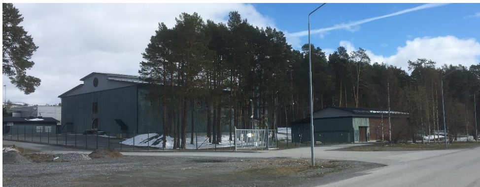
Det befintliga vattenverket sett från Storsjöstråket.
