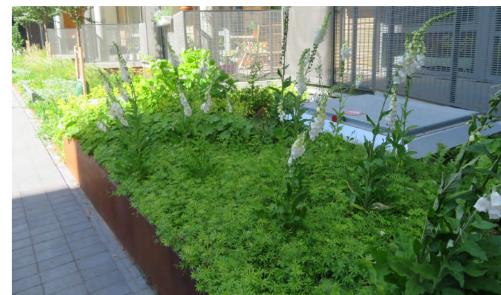
Exempel på dagvattenhantering inom gårdar, fotot visar en upphöjd regnbädd. Foto, ekosystemtjänstutredning, WSP 2023.
