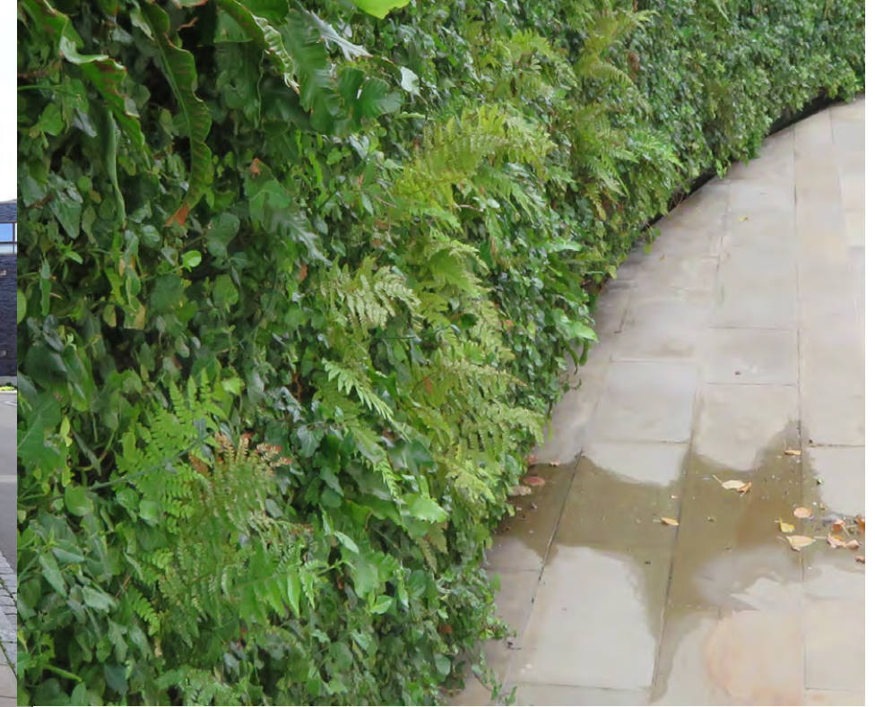
Växtvägg som utformas för att även ge god bullerdämpning kan anläggas på vindskyddad plats med växter anpassade till klimatzonen. (Foto. Ekosystemtjänstanalys WSP. 2023.)
