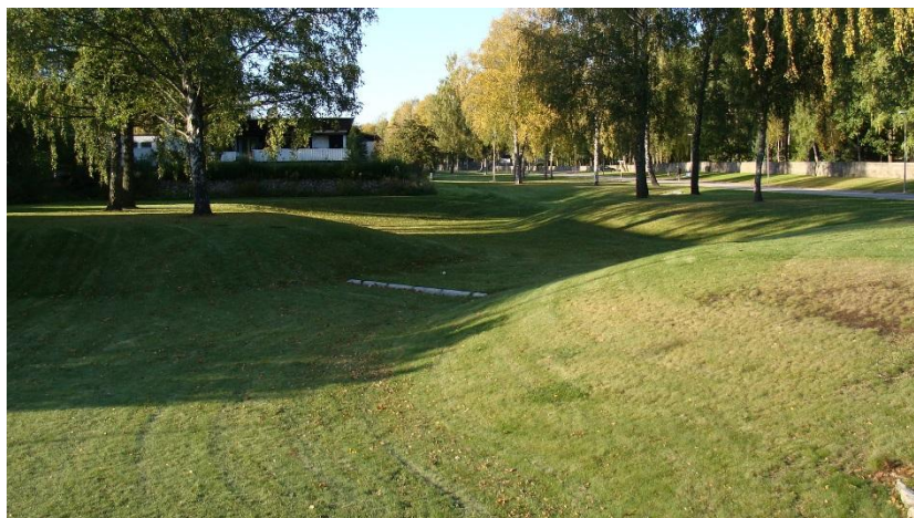
Figur 36: Exempelbild på en översvämningssyta.
