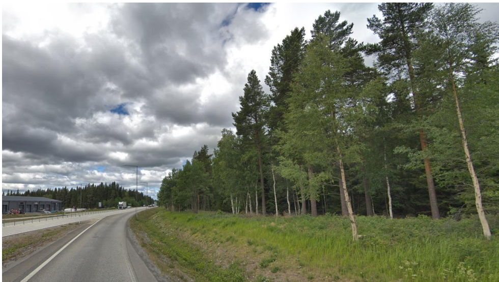
Vegetation närmast vägen i planområdet sett från E14 idag.
