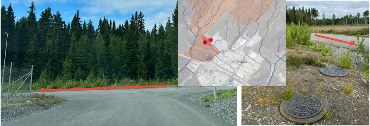
Figur 26. Huvudområdet och delområde 2 överlappar varandra där det idag har byggts en ny väg som syns enligt figuren. Vägen lutar mot skogen som visas i den västra figuren och från väst till öst som pilarna visar. Parallellt om vägen på dess södra sida finns idag även en dagvattenledning med dimension 400 mm anlagd enligt beteckning på brunn (BTG600 enligt äldre underlag från Östersund kommun mottaget 2024-07-12).
