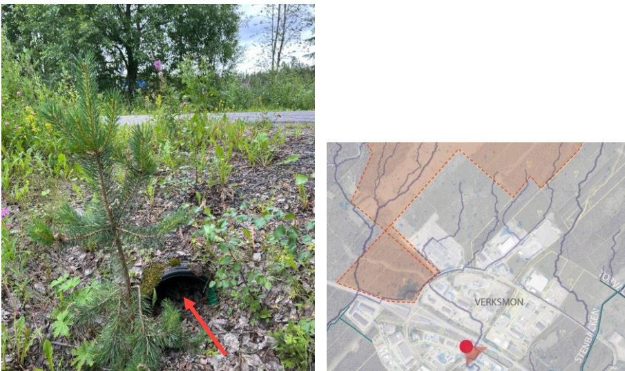
Figur 30. Trumma under gångväg i plast med dimension 400mm från dike som beskrivits i föregående figur. Vattnet rinner genom trumman mot diken på andra sidan gångvägen.
