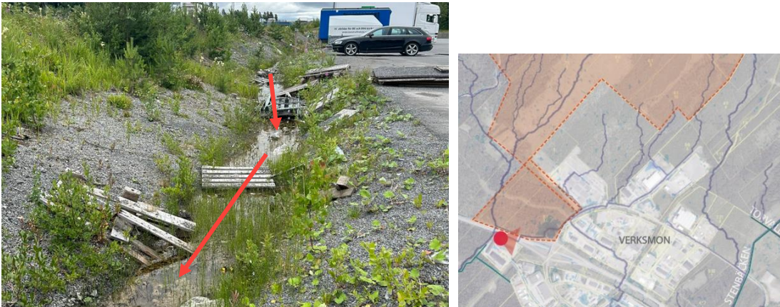
Figur 21. Lokalt dike för industriområde söder om E14. Diket är separerat från direkt avrinning från utredningsområdet genom fyllnadsmassor mot E14.
