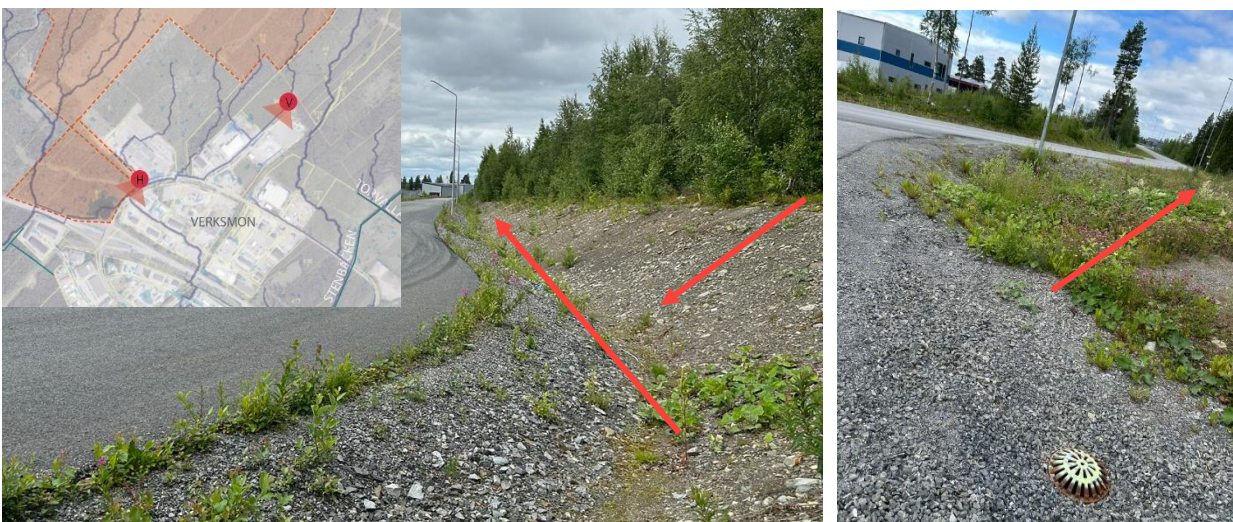
Figur 28. Vänster figur visar dike längs med lokalväg inom Verksmons industriområde. Dagvatten från skogsmark rinner mot diket som rinner vidare vid dimensionerande regn till ett befintligt dagvattensystem inom Verksmon. Höger figur visar kupolbrunn vart utlopp är
