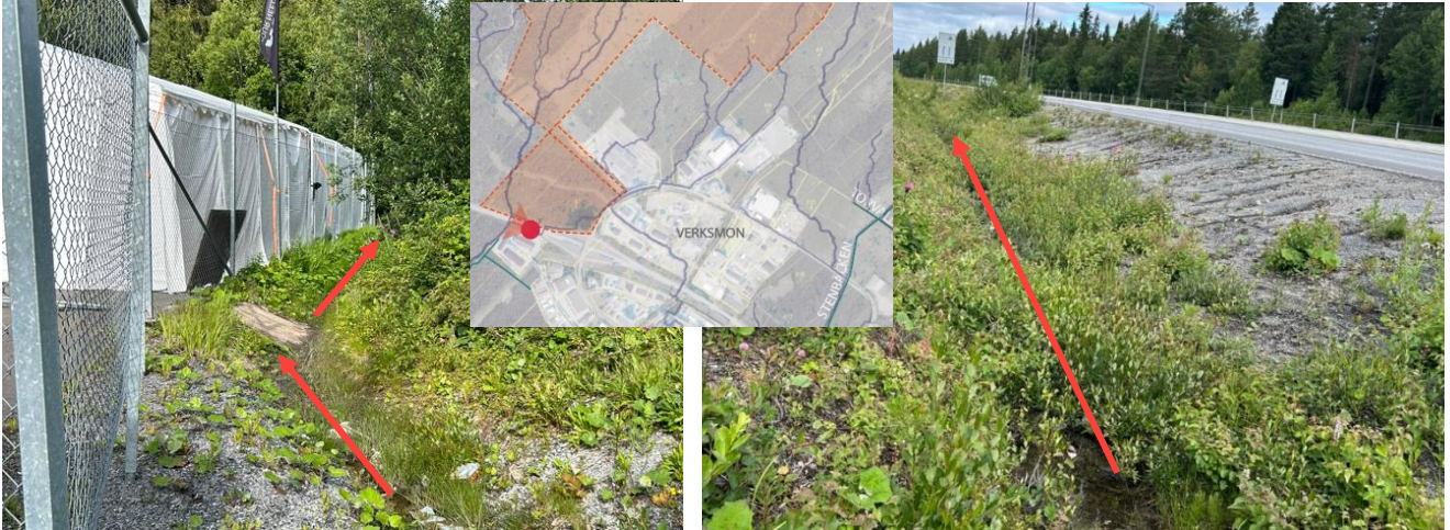
Figur 23. Visar två parallella diken söder om E14, separerade av en barriär av fyllnadsmassor. Det högra diket används för Trafikverket och det vänstra används av verksamheter inom ett industriområde. Dessa diken möts inom naturmark strax efter att dessa pilar möts vid barriärens slut.
