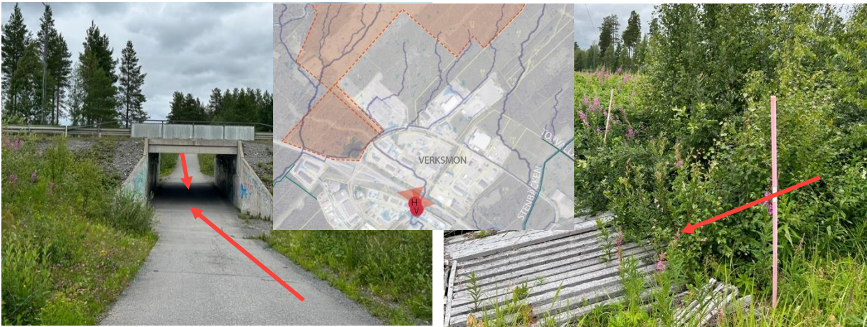
Figur 29. Vänster figur visar lågpunkt vid gångtunnel under E14 mellan Övre torvalla och Verksmon. Denna lågpunkt är vid skyfall en tydlig punkt där vattnet från Verksmon färdas till Övre Torvalla om marken är mättad och ledningar är fulla. Vid dimensionerande regn rinner vatten från Verksmon genom en trumma i betong med dimensionen 600mm. Figuren till höger visar skoterövergång för ett dike strax söder om E14 där trumman ansluts. Sikten är begränsad med mycket buskage och björkar vilket visar på att diket troligtvis ofta kan vara fyllt med vatten.
