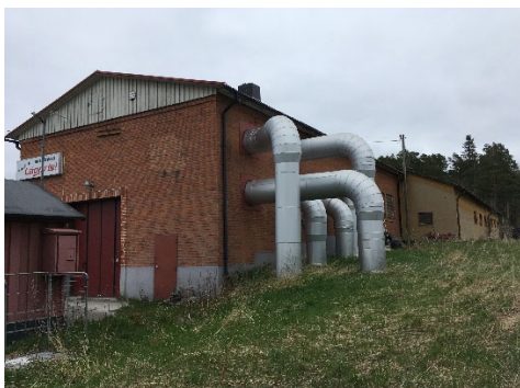
Pumphuset sett från sydväst
