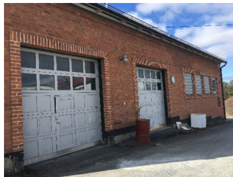
Pumphuset sett från nordost
