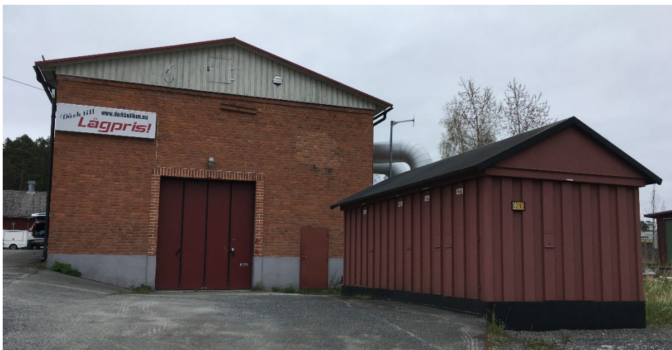
Pumphuset i tegel med transformatorstationen i förgrunden, vy från väster
