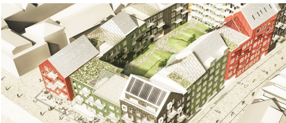
Varierat taklandskap med inslag av terrasser, växthus, takkupor och gavelmotiv i hörn. Kvarteret Tjärleken, Norrtälje Hamn, Arkitema Architects, 2018.
