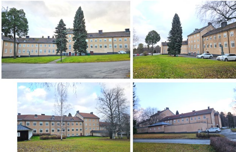
Bilder från planområdet tagna på fram- och baksida av befintlig institutionsbyggnad.
