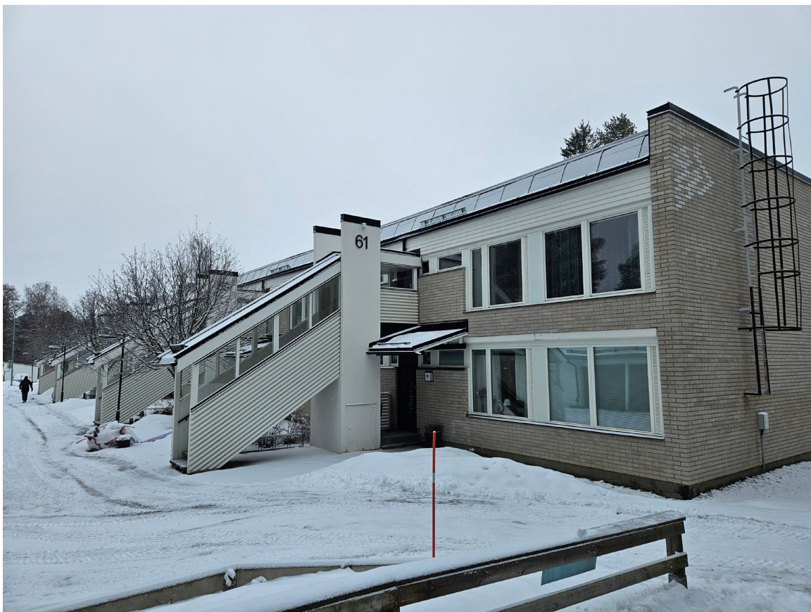
Figur 21: Foto som visar entrésidan med trappor på ett av flerbostadshusen i två våningar.
