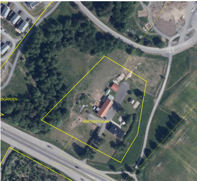
Figur 3.1 Ortofoto över befintlig fastighet. (Källa: Lantmäteriet 2025-08-29)
