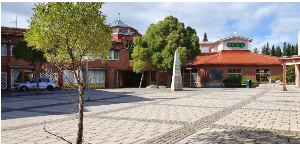
Figur 65 Torg och del av centrumbyggnad i Torvalla centrum
