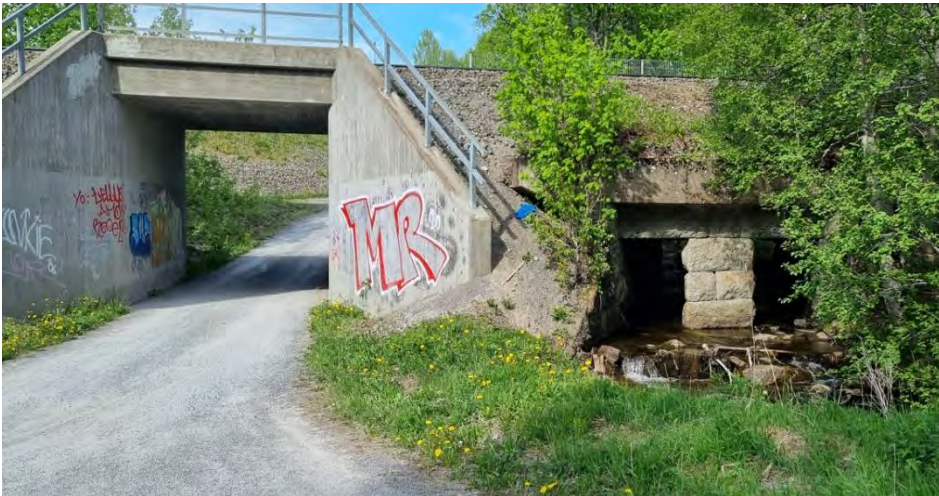
Figur 6-3 Järnvägen, stor stentrumma under järnväg, bredd = 1,3 m höjd = 1,7 m (två stycken).
