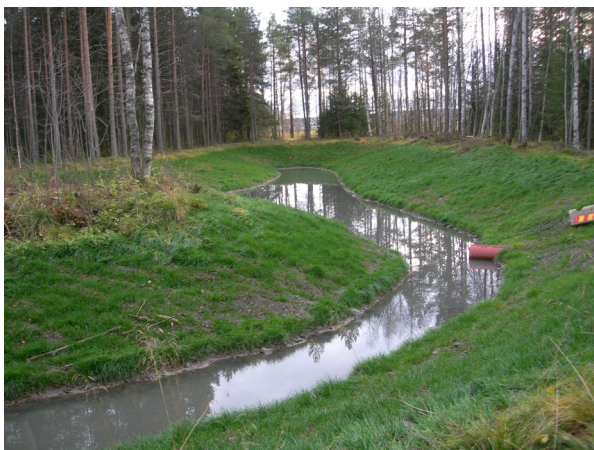
Figur 40 En dagvattendamm i Odenala.
