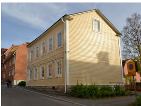
Kv. Slakteriet 7. 1885 Tullgatan 8
