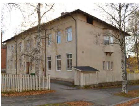
Kv. Pekkinnen 2. 1909 Arkitekt Edward Dahlbäck Litsvägen 12
