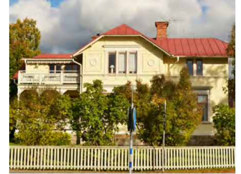
Kv. Färgaren 5. 1901 (q) Arkitekt Frans Bengtsson Strandgatan 15 A-B
