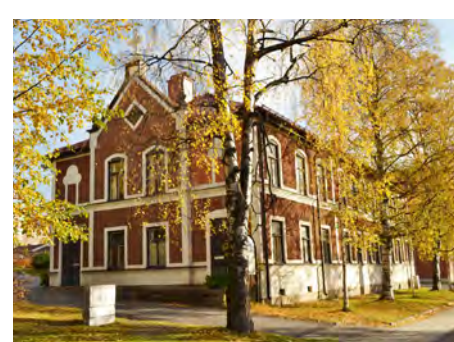
Kv. Logen 5. 1883 Betelkyrkan med uthus Kyrkgatan 51
