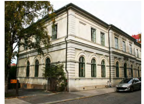
Kv. Riksbanken 2. 1885 Arkitekt Magnus Isaeus Övervåning Erik Lallerstedt, 1927 Storgatan 44
