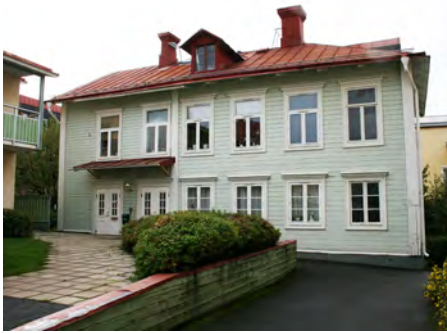
Kv. Riksbanken 6. 1860-tal Ombyggt ca 1880 (q) Gårdshus. Köpmangatan 51 C
