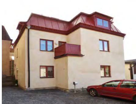
Kv. Färgaren 2. 1890. (k) Gårdshus uppfört 1890-t, rappat 1912.
