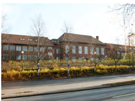
Kv. Läroboken 3. Wargentinskolan . Om/tillbyggnad 1935. Arkitekt Cyrillus Johansson.
