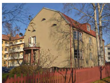
Kv. Vadmalsväven 3. 1923 Arkitekt Ivar Ståhl Samuel Permans gata 25
