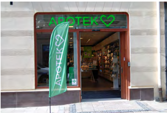
Prästgatan. Ny dörröppning i äldre byggnad. Liten markförhöjning i gatuplan, liten ramp inne.
