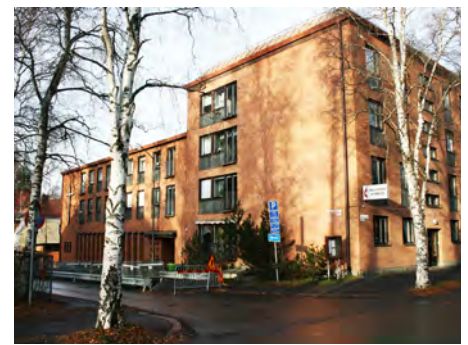
Kv. Skavjärnet 3. 1961 Bostadshus/Methodistkyrka Arkitekt Elmer Husman Regementsg/ Magistratsgränd
