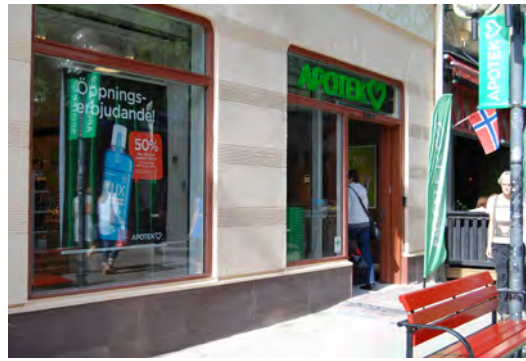
Prästgatan. Ny dörröppning i äldre byggnad. Liten markförhöjning i gatuplan, liten ramp inne.
