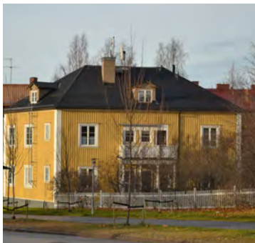
Kv. Skogsskiftet 3. 1924 Bostadshus och uthus. Södra Gröngatan 45
