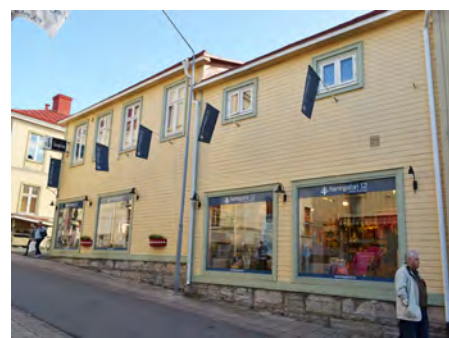
Kv. Pantbanken 2. 1896 (q) Hamngatan 12
