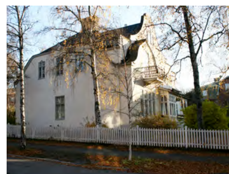
Kv. Pekkinnen 1. 1907 Villa med uthus Arkitekt Gustav Hultquist Färjemansgatan 9
