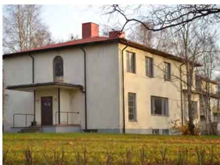
Kv. Ångern 5. 1932. " Funkisvilla " Arkitekt Anders Ekman Stuguvägen 37
