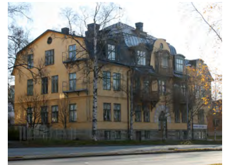
Kv. Borgmästarlotten 4. 1907 (q) Arkitekt Edward Dahlbäck Rådhusgatan 5
