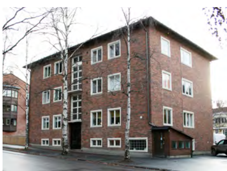
Kv. Skavjärnet 1. 1938 Arkitekt Arvid D Persson Biblioteksgatan 22
