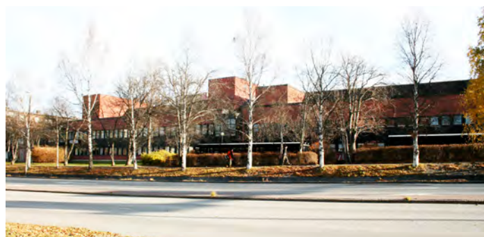
Kv. Läkarboken 5. 1973-75 Socialhögskolan Arkitekt Bo Holmberg FFNS Rådhusgatan 15- 17
