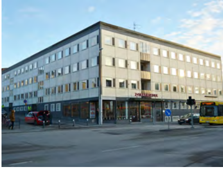
Kv. ABC-Boken. Ca 1960 Arkitekt Holger Jonsson Rådhusgatan 31
