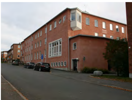
Kv. Arken 8. (q) Invändigt konstverk av Lennart Rohde "Paket i långa banor", 1948. Rådhusgatan 56
