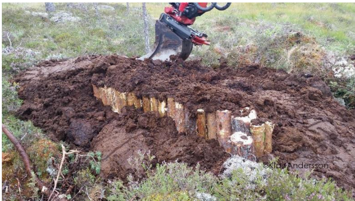
Figur 10. Bilden visar packning av ensidigt trädämme. Det är viktigt att torv packas in överallt så att det inte bildas luftfickor. Detta är särskilt känsligt under virket som löper liggande över diket.
