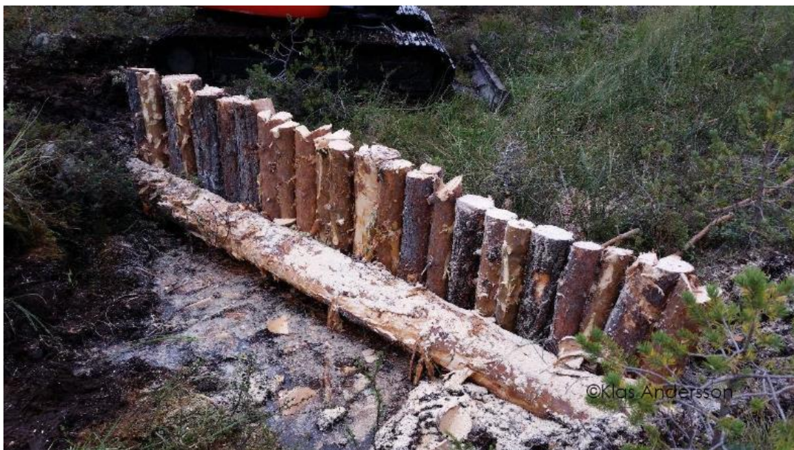
Figur 8. Bilden visar ett dämme i tidigt stadie. Här har diket som löper snett nerifrån vänstra hörnet och upp genom höger mitt på bilden grävts ur och en stödstock har angjorts i dikesvallarna. Som kan skönjas på bilden är det synliga diket relativt smalt men den urgrävda ytan är betydligt större. Detta görs för att få till ett tätt och stabilt dämme som håller över tid. En gripklo är ett tillbehör som bör krävas att entreprenören har på maskinen. Detta verktyg underlättar arbetet med virke
