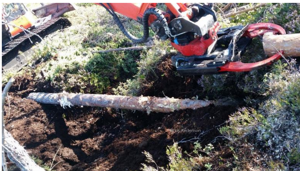
Figur 9. Dämme med ensidig träkärla där trädelen är under färdigställande. Det krävs oftast minst två personer på plats för att göra dessa dämmen: maskinist och person som kan hantera motorsåg och göra bedömning av höjd och bredd på dämmena. Själva träkärlan behöver inte löpa hela vägen ut i terrängen från diket utan det räcker ofta att det går in 0,3–0,6 meter i dikeskanten för att det ska vara stabilt.
