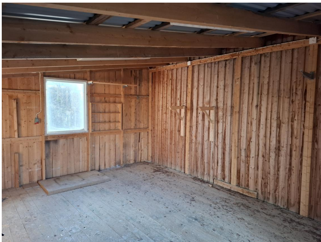
Vidbyggd oisolerad förrådsdel huvudbyggnad
