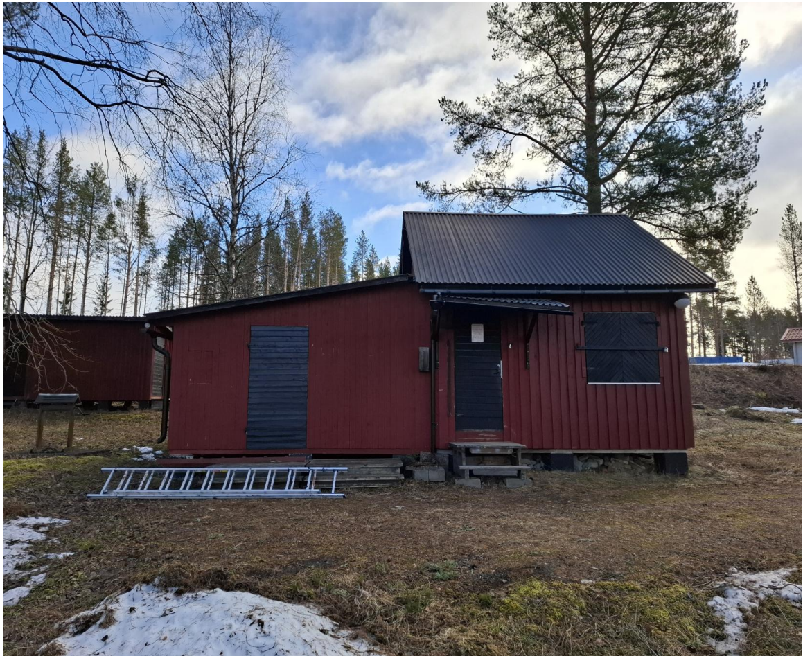
Huvudbyggnad fasad. Den högra delen är isolerad och har vindsutrymme. Den vänstra delen är oisolerad.
