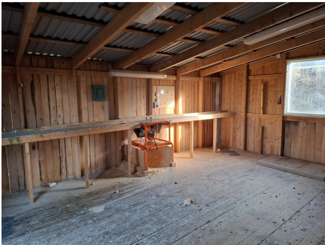
Vidbyggd oisolerad förrådsdel huvudbyggnad
