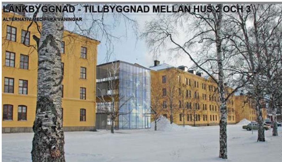
Byggnad 2 och 3 samt mellanliggande länkbyggnad från nordväst
