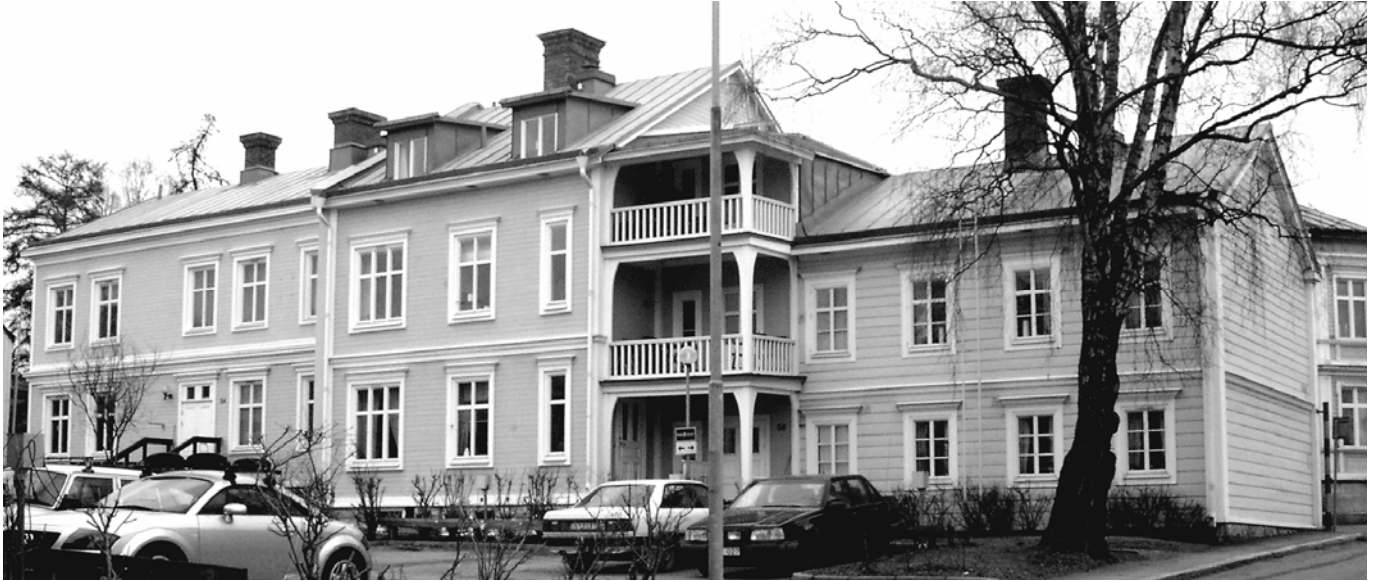
De sammanbyggda husen från 1887, 1910 och 1850-talet sedda från gårdssidan.
