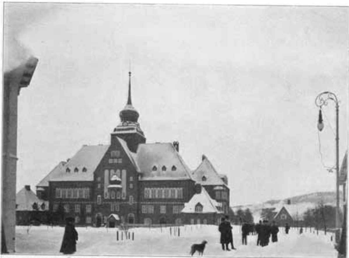
FIG. 8. RÅDHUSETS BAKSIDA OCH BIBLIOTEKSBYGGNADEN (RITAD AF RÅDHUSETS ARTITEKT).
