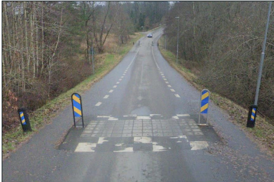
Figur 30. Åtgärder för integrerad cykeltrafik på Västra Fageredsvägen utanför Lindome, Mölndals kommun. Bildkälla: Google
