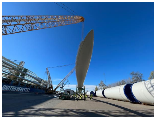
Ett blad är 80 meter. Bladen har så kallade "hajtänder", vilket är en konstruktion för ljudminimering. Profileringen sitter i bakkanten av bladen.
