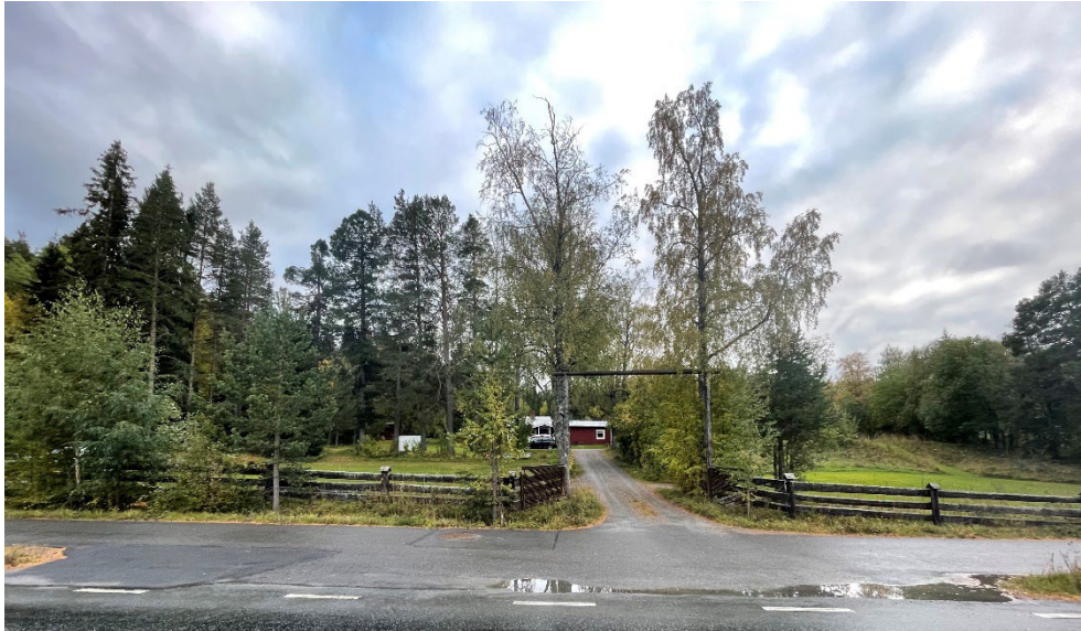
Bild 11. Befintlig byggnad ligger indragen från väg 592. Foto Sökande.
