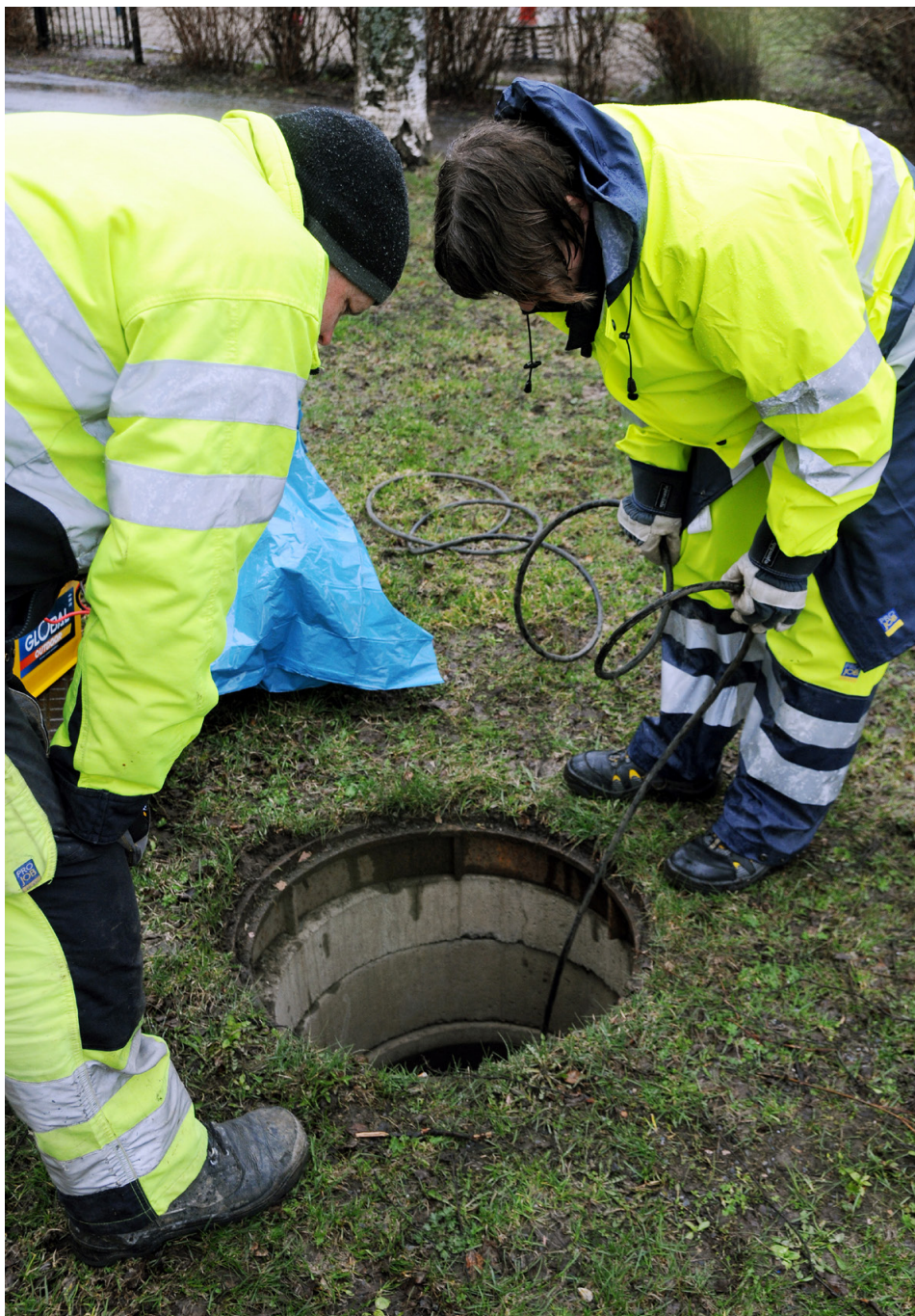
Bild 4.3 Installation av mätutrustning i dagvattenbrunn
