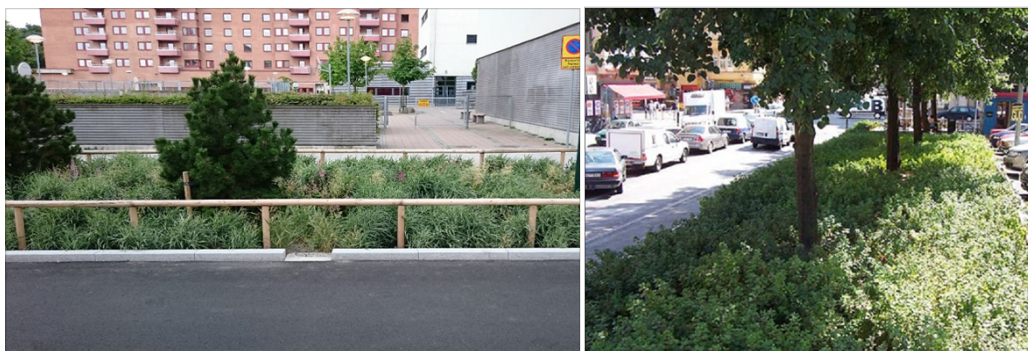
Figur 12. Till vänster, nedsänkt regnbädd med inlopp genom nedsänkt kantsten. (sigmacivil.se). Till höger, regnbädd med trädplantering i anslutning till parkering, foto: Björn Embrèn.
