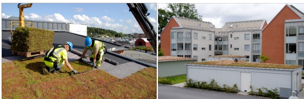
Figur 16. Anläggning av gröna tak till vänster och färdigt tak på miljörum till höger, bilder från vegtech.se.
