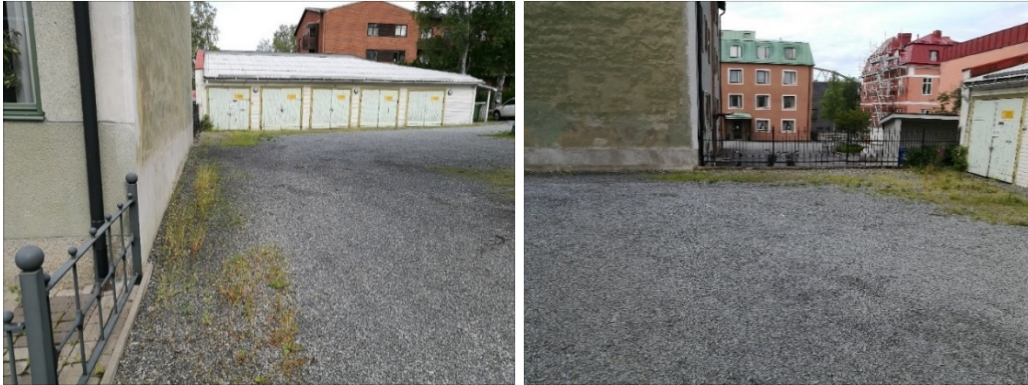
Figur 3. Grusplan på fastigheten med västlig lutning mot stödmur. Stödmuren är placerad mellan byggnaderna på den högra bilden under gjutjärnsräcke.
