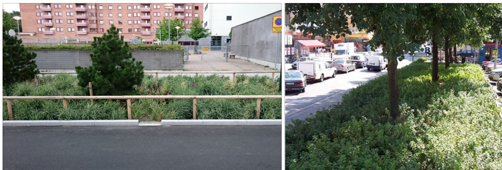
Figur 15. Till vänster, nedsänkt regnbädd med inlopp genom nedsänkt kantsten. (sigmacivil.se). Till höger, regnbädd med trädplantering i anslutning till parkering, foto: Björn Embren.
