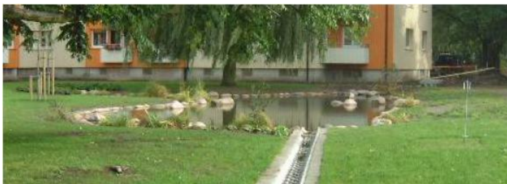
Figur 4. Öppen fördröjningsdamm i grönyta
