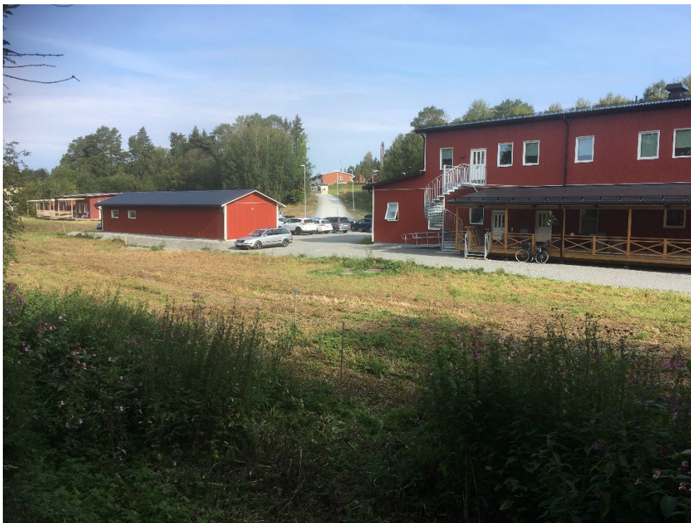
Kontors- och vårdbyggnad i förgrunden. De gruppbyggda småhusen i bakgrunden.
