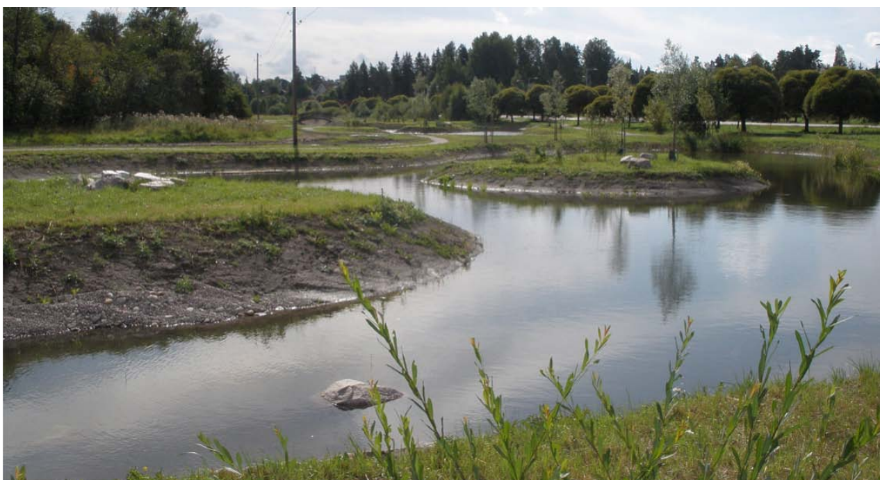
Figur 12. I öppna dammar kan dagvattnet renas, genom att vattenföringen (hastigheten på vattnet) sänks och partiklar och föroreningar sedimenterar. Utflödet från dammen till slutlig recipient (mottagare) blir mer avjämnat och risken för översvämningar minskar.
