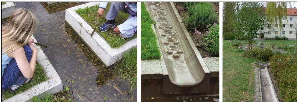
Figur 16: Dagvattenkanaler på innergård. Till vänster, kanal med krossbotten med bräddning till grönyta. Till höger, kanal till mindre damm på innergård.
