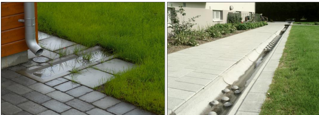
Figur 12: Vattenutkastare och dagvattenrännor, bilder från steriks.se.
