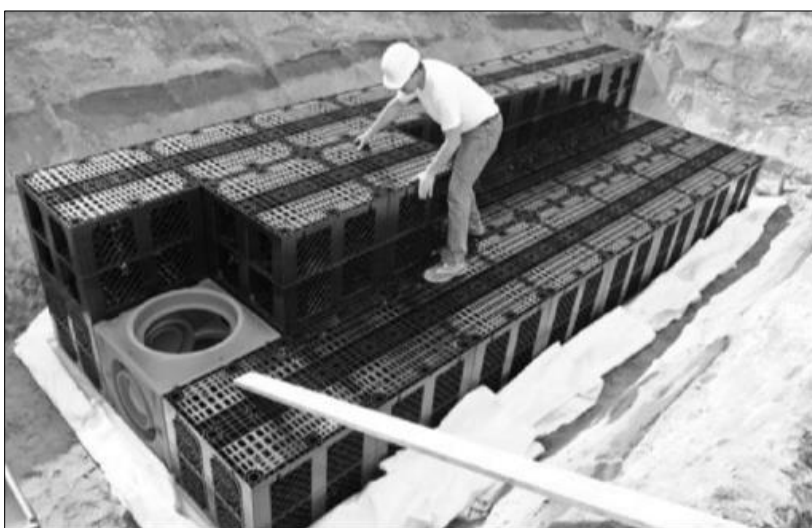
Figur 10: Dagvattenkassetter ( www.rehau.com ).
