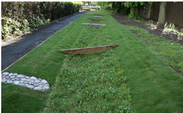
Figur 15 - Uppsamlingsdike med konstruerade sektionering/dämmen för att främja möjlighet till infiltration (Vadstena kommun, 2021).
