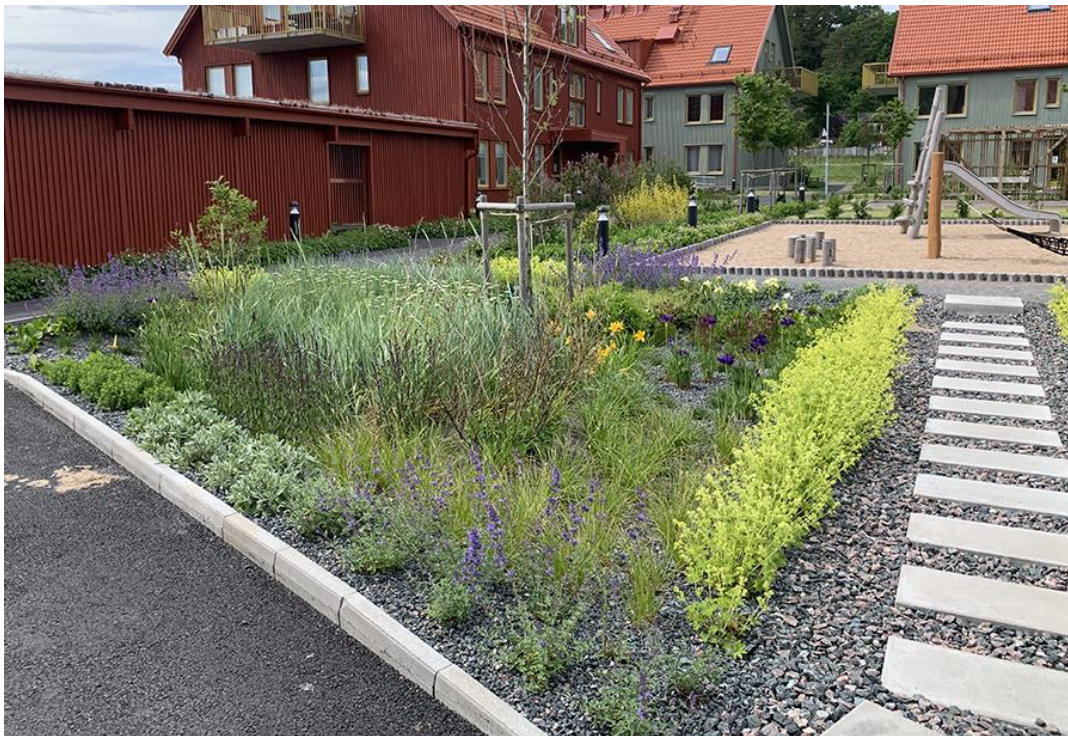
Figur 17 - Biofilteranläggning/Regnträdgård med planteringar med växtbäddar och krossmaterial (Hasselfors garden, 2023).
