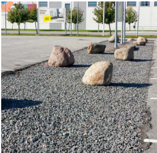
Figur 19 - Exempel på makadamdike inom en parkeringsyta från Malmö (Göteborgs stad och Ramböll, 2017).
