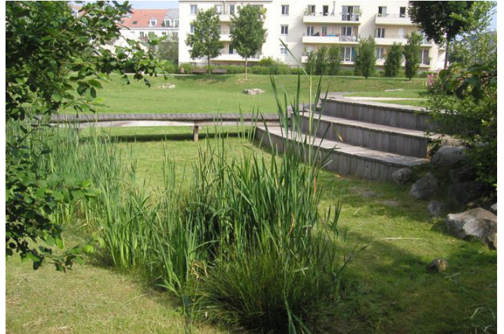
Figur 23 - Torrdamm med inlopp (vänster) och torrdamm som integrerats i gestaltningen av området (höger) (Svenskt vatten, 2019).
