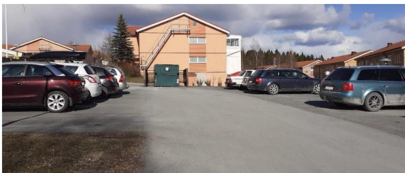
Figur 8. Foto som visar markparkering C.
