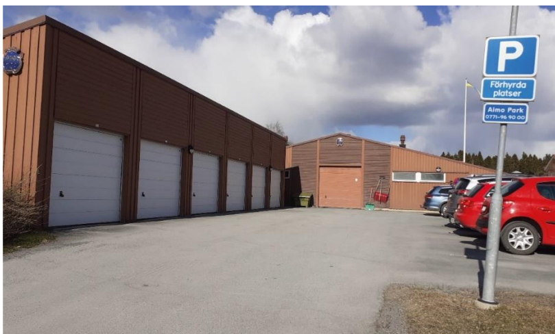
Figur 7. Foto som visar infart till befintligt soprum, garage och markparkering B.
