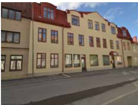
Kv. Färgaren 2. Uppfört 1890-t. Rappat 1912 Köpmangatan 36.
