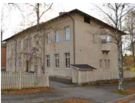
Kv. Pekkinnen 2. 1909 Arkitekt Edward Dahlbäck Litsvägen 12
