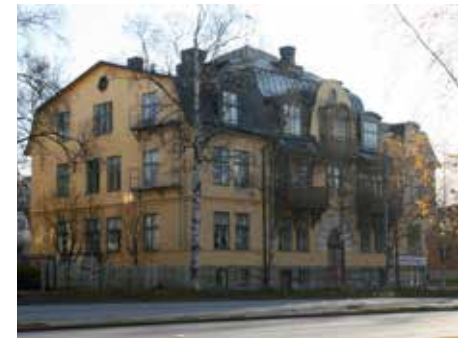
Kv. Borgmästarlotten 4. 1907 (q) Arkitekt Edward Dahlbäck Rådhusgatan 5
