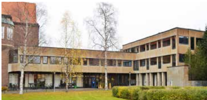
Kv. Lagboken 3. 1971 Nämndhuset, hus B- rådhuset Wimanarkitekterna, Gösta Wiman Rådhusgatan 21
