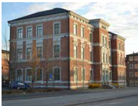
Kv. ABC-boken 3. 1893 Södra skolan . Arkitekt Adolf Kjellin Påbyggd 1914. Rådhusgatan 35
