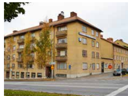
Kv. Monopolet 3. 1950 Uppfördes av Godtemplarna Arkitekt Cyrillus Johansson Grängsgatan 9/ Kyrkgatan
