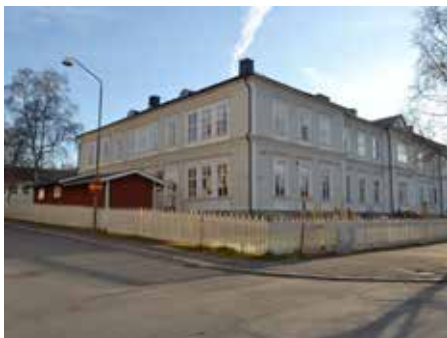
Kv. Stådraden 1. 1883. (Q) Norra Skolan. Arkitekt A. E. Melander Regementsgatan 14-16
