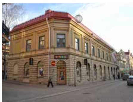
Kv. Gästgivaren 1. 1889 Jämtlands folkbank Byggmästare J Pettersson. Storgatan 33
