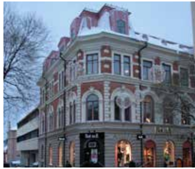
Kv. Läkaren 13. 1898 Godtemplarbanken Byggmästare JA Hellström Prästgatan 36
