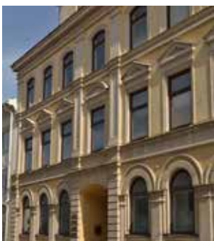
Kv. Staben 9. 1884 Storgatan 47
