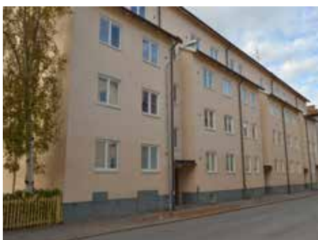
Kv. Fialbanken 10. 1940-t. (k) Arkitekt Axel Grape Köpmangatan 46 A-C
