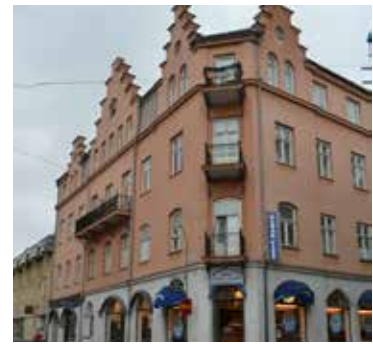
Kv. Läkaren 14. 1886. Ombyggt 1905 Arkitekt Edward Dahlbäck Storgatan 31
