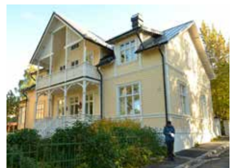
Kv. Bryggaren 5. 1843. Ombyggt 1879 och 1905 (q) Biblioteksgatan 13
