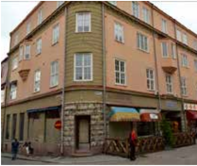
Kv. Rektorn 11. 1917 Arkitekt Frans B Wallberg Storgatan 30
