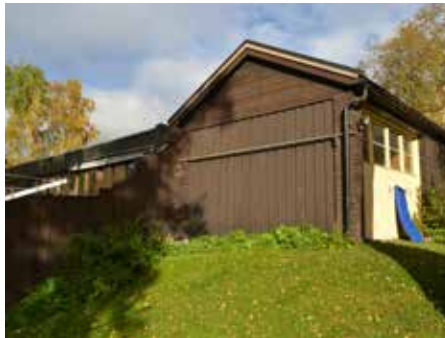
Kv. Filialbanken 5. 1924. (q) Uthus. Strandgatan 20.
