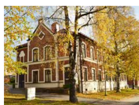
Kv. Logen 5. 1883 Betelkyrkan med uthus Kyrkgatan 51
