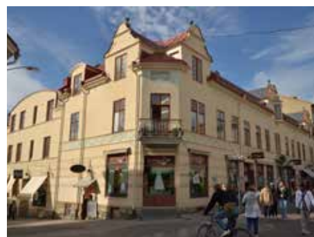
Kv. Gästgivaren 3. 1880. Bagare Åslunds gård . Ombyggnad 1900, ark Per Österlund. Tillbyggnad 1907, ark Knut G Gyllencreutz. Prästgatan 40
