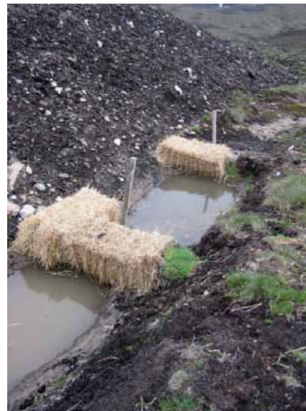
Halmbalar förhindrar slamtransport och grumling vid vindkraftverk i Skottland
