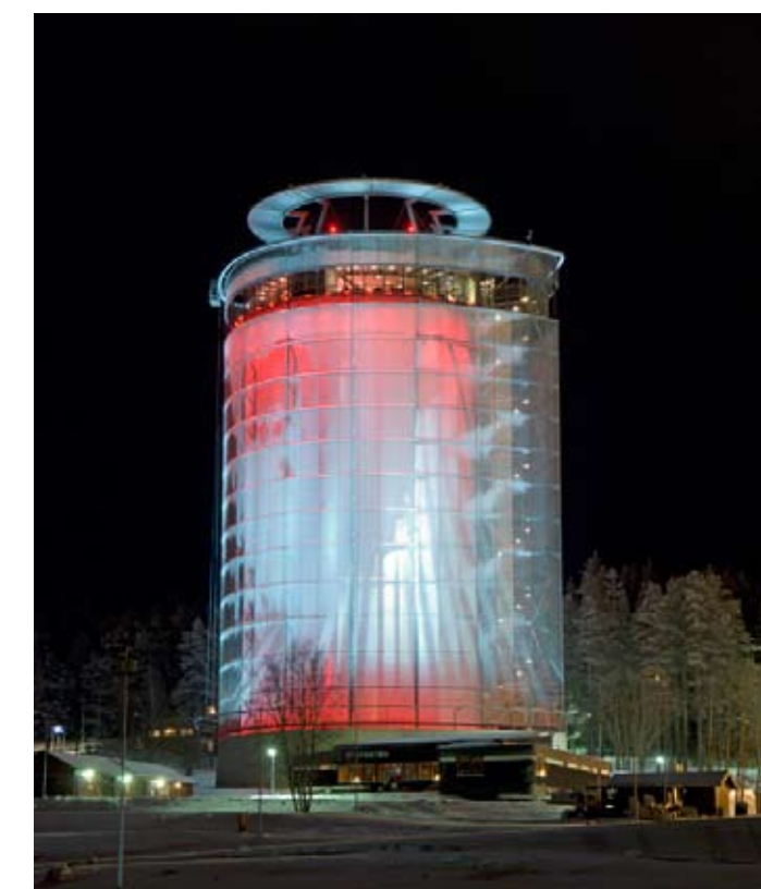
Arctura, en varmvattenackumulator för kraftvärmesystemet i Östersund
