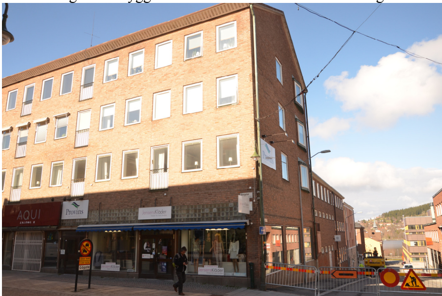
Bild 3. Foto över byggnaden. Det är både den högre delen utmed Storgatan och den lägre utmed Törnstens gränd som är kulturhistoriskt värdefull.
