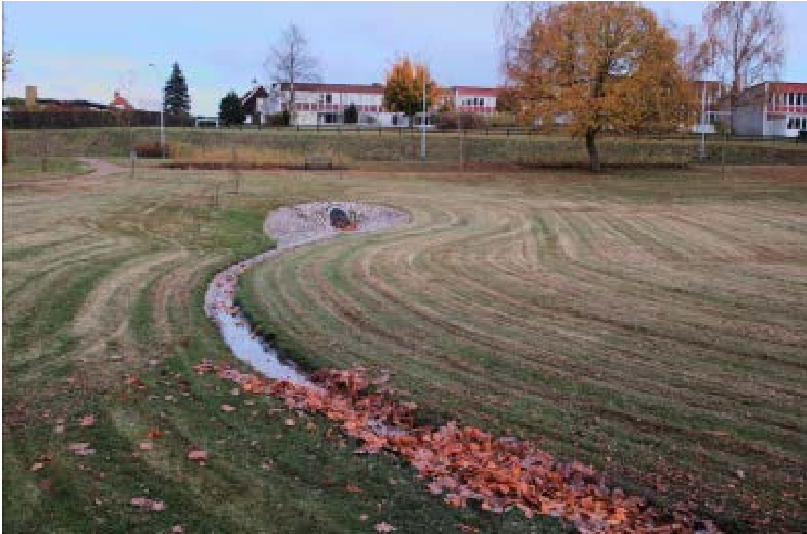
Exempel på överdämningsyta
