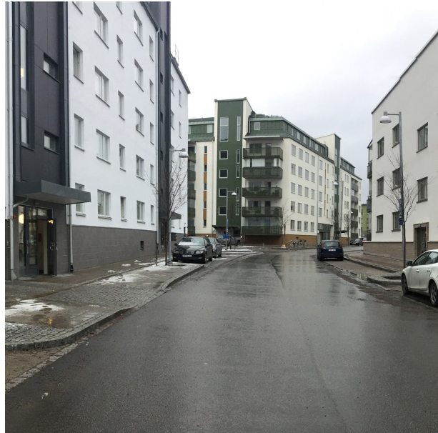
Bostasgata med tydliga och uppglasade entrépartier mot gata och första bostadsvåningen upphöjd från gatan
