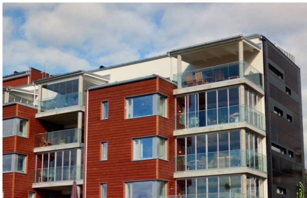
Inglasade balkonger som kombinerats med livförskjutningar så att de upplevs som en integrerad del i fasadgestaltningen. Stadsdel norr, Östersund
