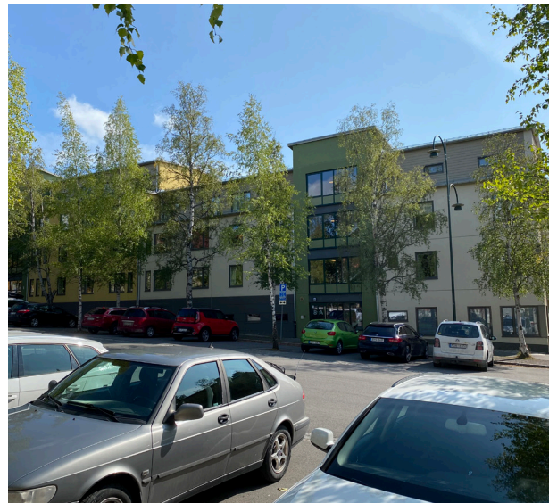
Trappande bebyggelse beskriver terrängen och knyter an till byggnadssätt och karaktär i staden i övrigt, Artillerigatan Östersund
