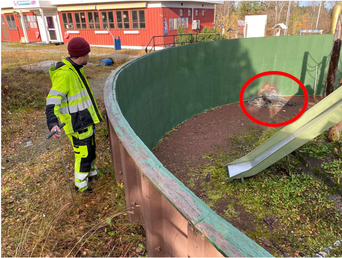
Figur 0.20 "Apgropen". Berg i dagen inringat på ca 1,5 meters djup under markytan. Troligtvis delvis uppfyllt.
