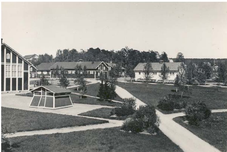
Bild 24. Den ljusa putsade stenbyggnaden till höger på fotot är stallet som det såg ut innan det försågs med panel. Byggnaden till vänster var regementets äldsta stall som byggdes 1911, byggnad 9, och som revs på 1970-talet.
