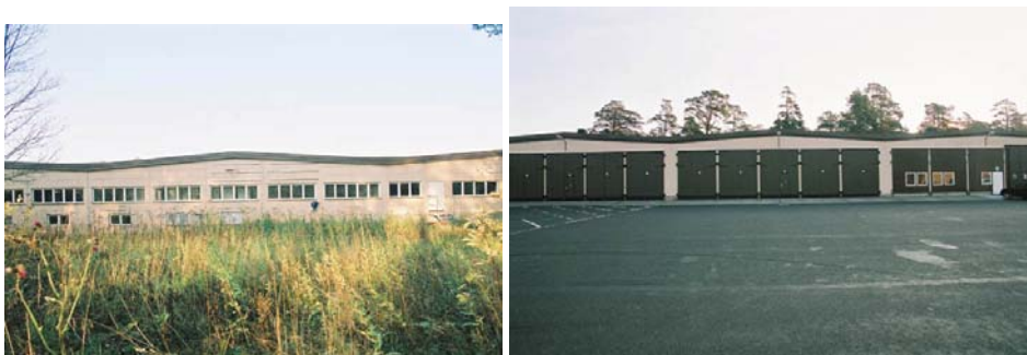
Bild 35,36. Garage byggt år 1970.
