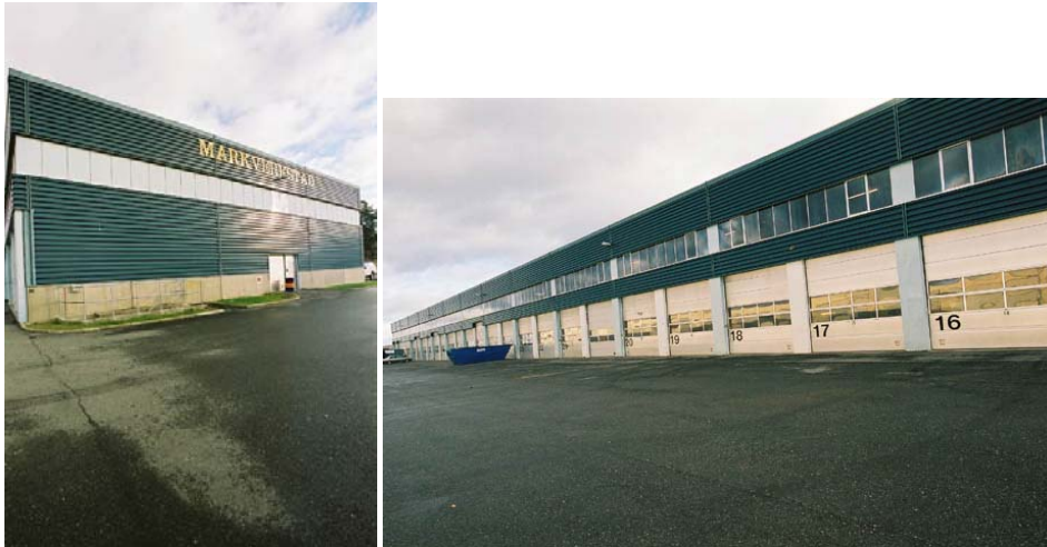
Bild 34, 35. Miloverksta- den byggd år 1980.
