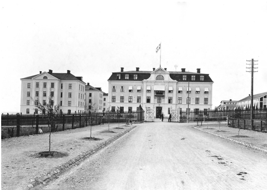
Bild 12. Foto av kanslihusets södra fasad från 1910-talet med staketet som omgav regementsområdet och grunden av trä.
