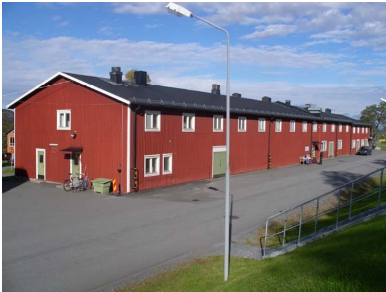
Bild .29 Byggnad 41 inrymmer idag främst kontorsutrymmen.
