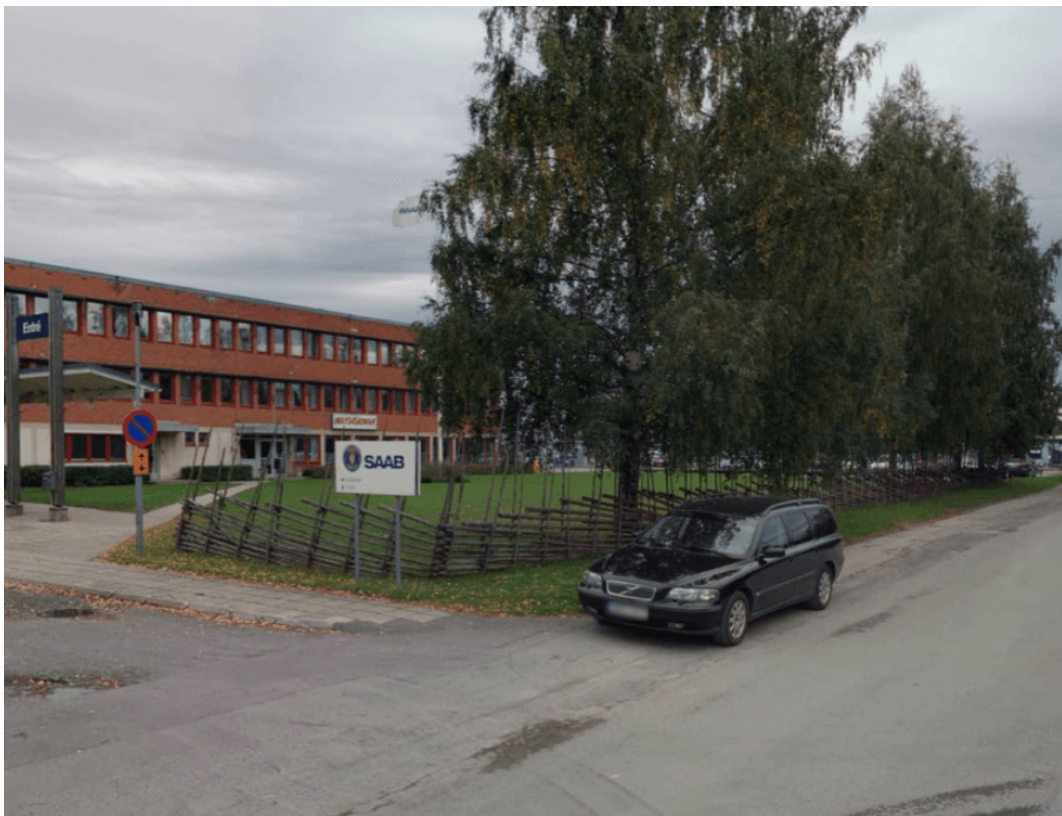
Figur 5: Befintlig utemiljö vid entrén på fastigheten Upplaget 1
