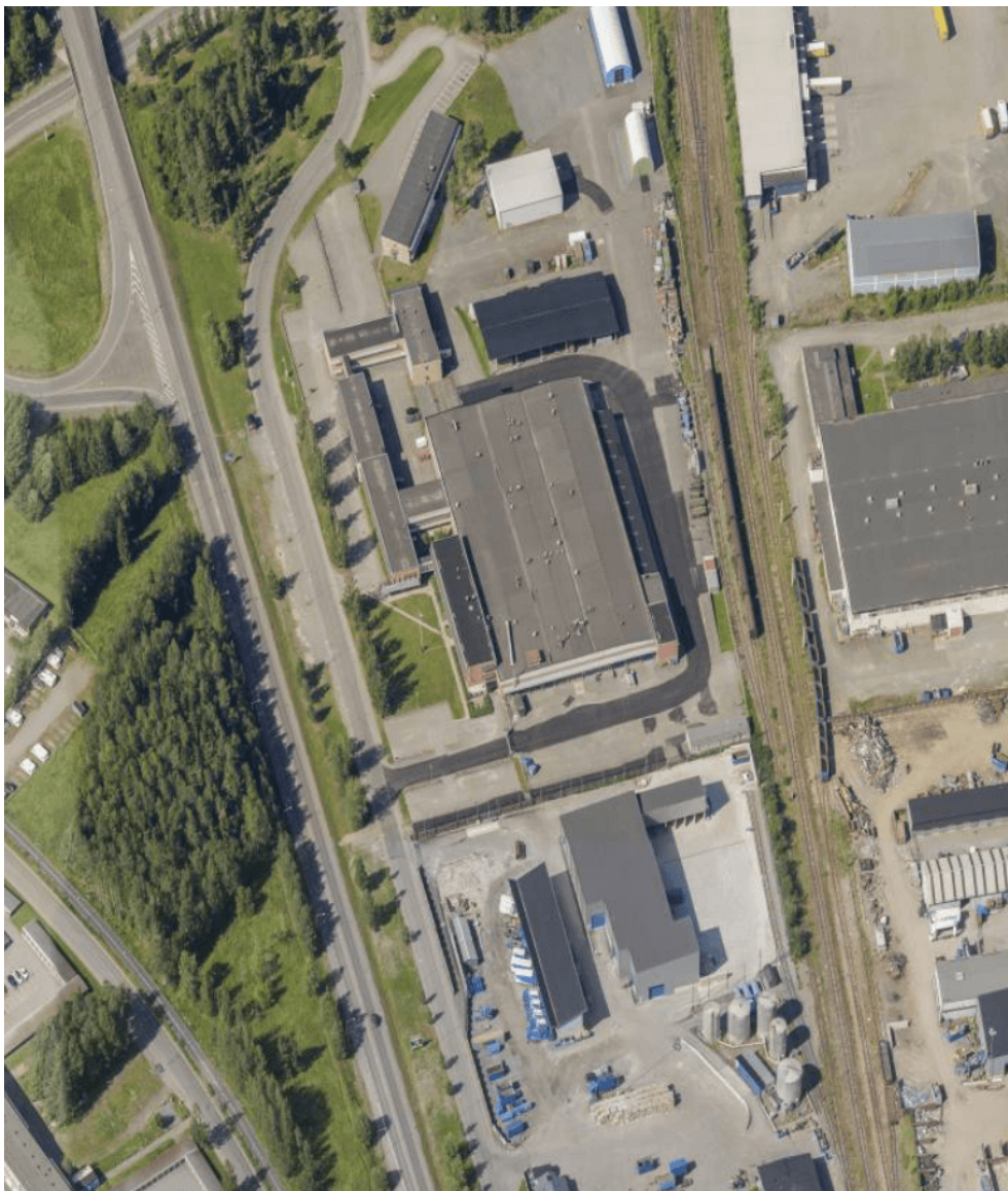
Figur 6: Flygfoto över byggnaderna inom planområdet
