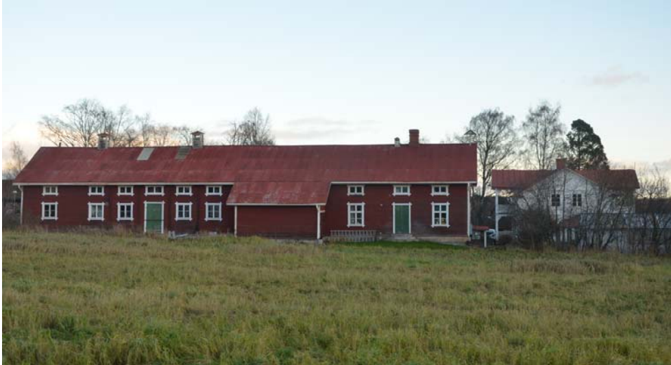
Bild 4. Ladugårdsbyggnaden på Konstnärsgården.
