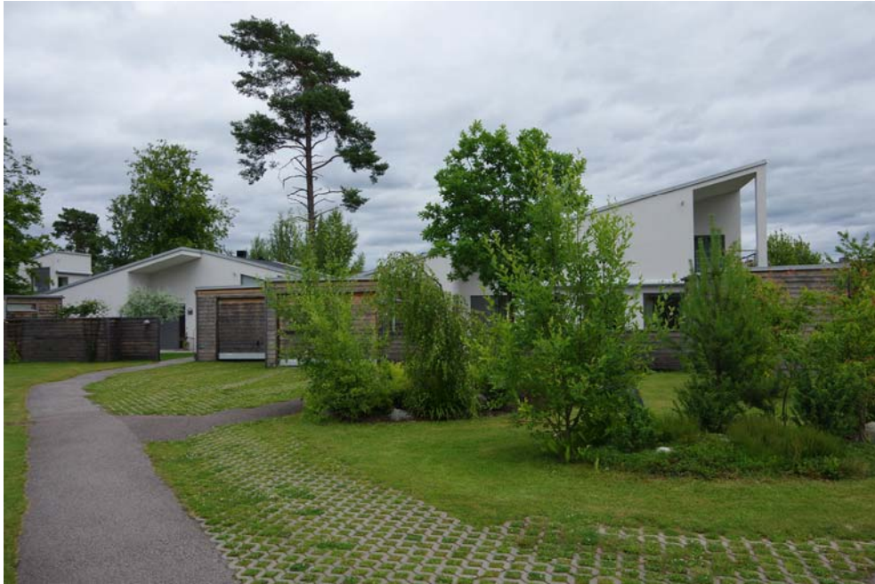
Figur 3. Bilden är en referens- och inspirationsbild till en grön miljö som visar genomsläpplig markyta där körbara miljöer kan vara fotgängarvänliga. Fotograf: Gisteråsjostrand Arkitektur AB / Ingemar Sjöstrand
