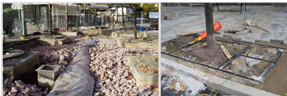
Figur 13. Makadamlager och utplacering av trädgallerram, foton: Björn Embrèn, Anders Ohlsson Sjöberg.
