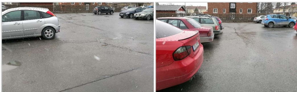
Figur 4. Parkering på fastigheten Rödhaken 6 med två lågpunkter mellan parkeringsplatserna.
