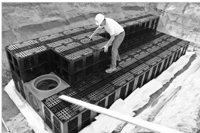
Figur 12. Dagvattenkassetter (www.rehau.com)
