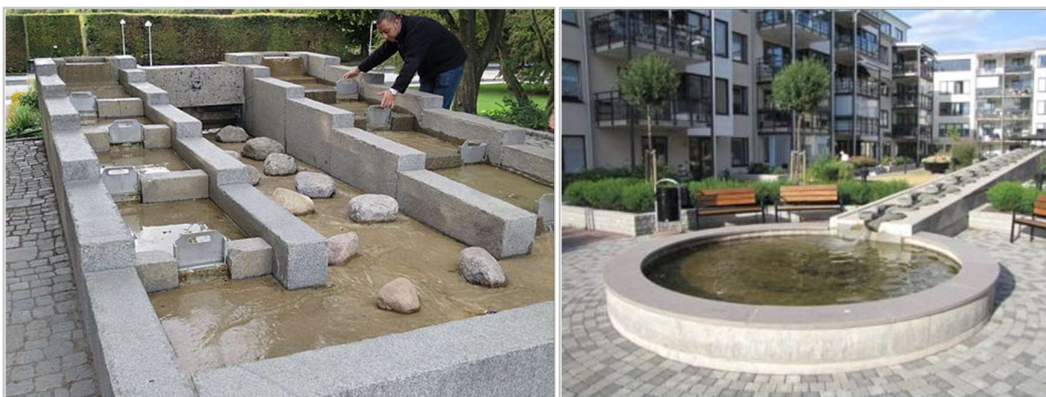
Figur 16. Exempel på dagvattenelement, till höger Wikimedia Commons, Jorchr och till vänster flowforms.se.
