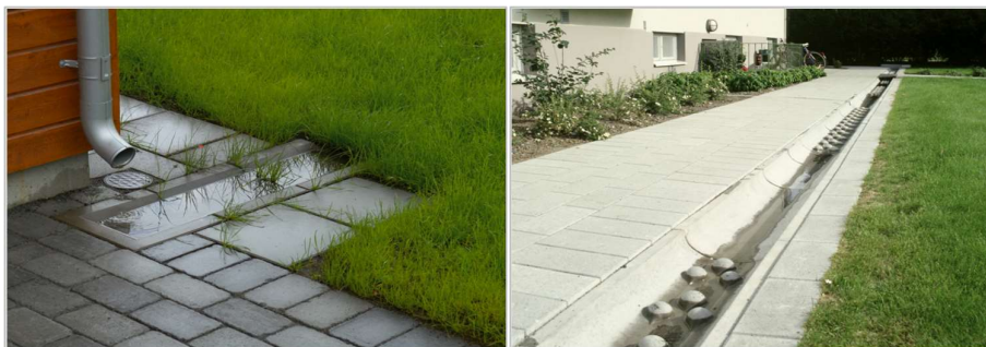
Figur 17. Vattenutkastare och dagvattenrännor, bilder från steriks.se.
