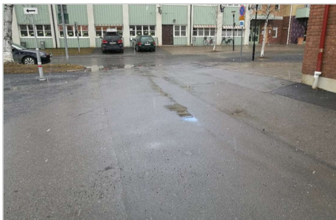
Figur 5. Lågpunkt vid infart till parkeringen på fastigheten Rödhaken 6.
