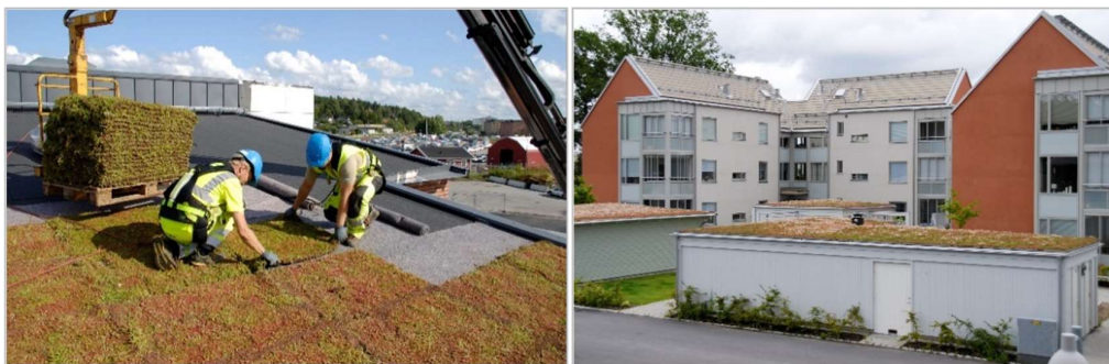
Figur 18. Anläggning av gröna tak till vänster och färdigt tak på miljörum till höger, bilder från vegtech.se.
