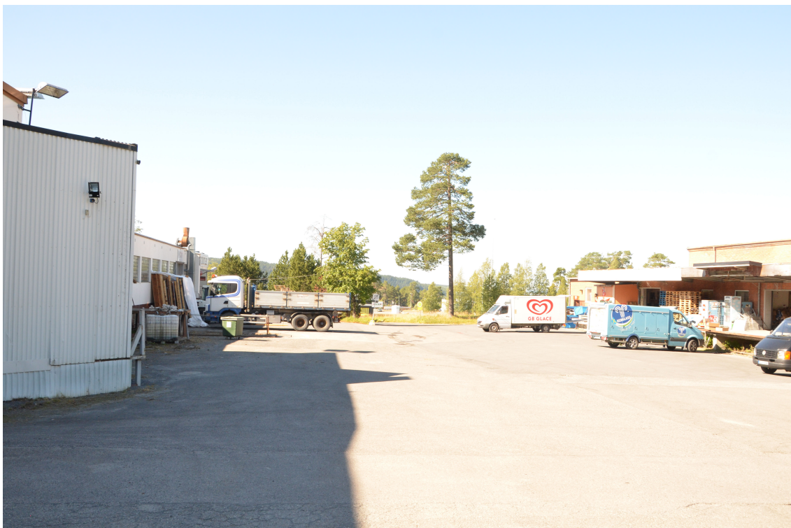
Bild 3. Foto över industrifastigheterna. Den nya entrévägen föreslås ungefär vid glassbilarna. Byggnaden till höger i bild kommer att rivas för att göra plats åt vägen. Marken på bilden kommer att behöva sänkas något för att inte få allt för stor lutning på den nya vägen.
